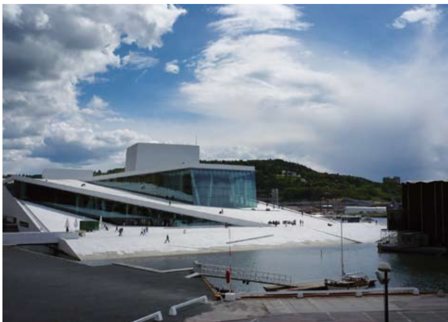
Obr. 2. Nová budova opery na pobřeží Oslofjordu.
